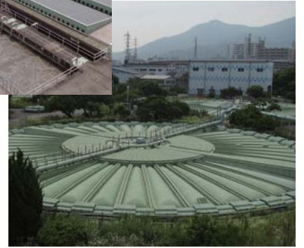
皇后崎浄化センターの沈澱池
