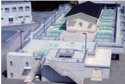
穴生浄水場「高度浄水処理施設」
