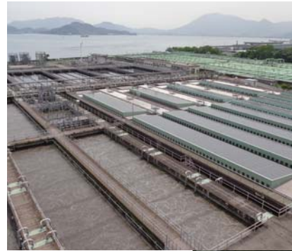
日明浄化センターの反応タンク
