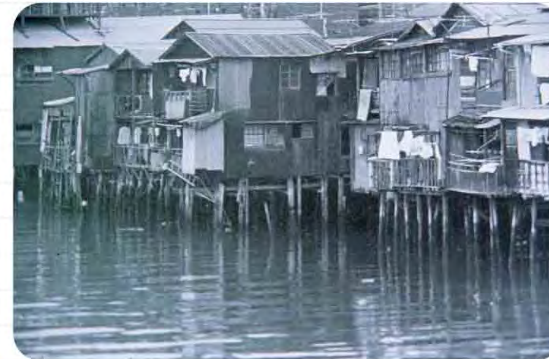
▲紫川沿いに密集する違法建築。汚水は川へ流された。
