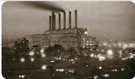
▲1955년의 규슈전력 나카바루 발전소. 1964년에 해체될 때까지 나카바루의 6개 굴뚝으로서 주민들에게 친숙한 존재였다.
